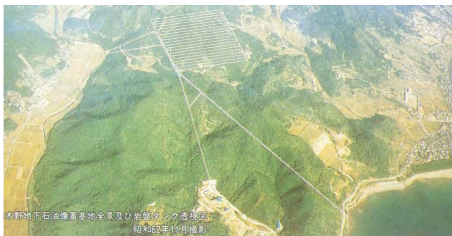
串木野石油備蓄基地パンフレット
